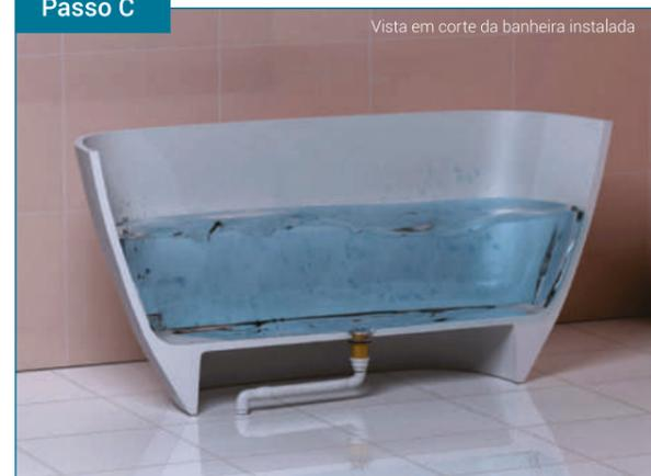
Retorne a banheira à **posição original** e encha de água para testar se ocorrem vazamentos.
